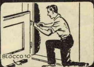
**T**RACCIATE SUL BATTENTE altre due linee, una 20 mm. sopra, e una 20 sotto quella già tracciata ad un metro dal fondo. Portate i supporti vicino a queste linee e tagliate con un saracco la porta in due sezioni, gettando via la striscia di 40 mm. Occorre fare molta attenzione a questo lavoro, se la porta è del tipo a due spessori.
